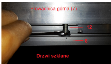
Fot.7 Miejsce mocowania wózka po stronie podfrezowania profilu
